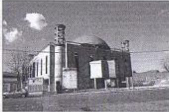
Depuis décembre dernier, le chantier est arrêté
