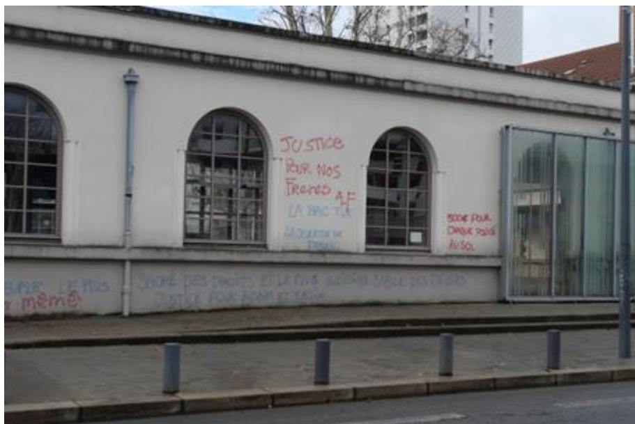
Inscriptions sur le mur du gymnase Ampère.
